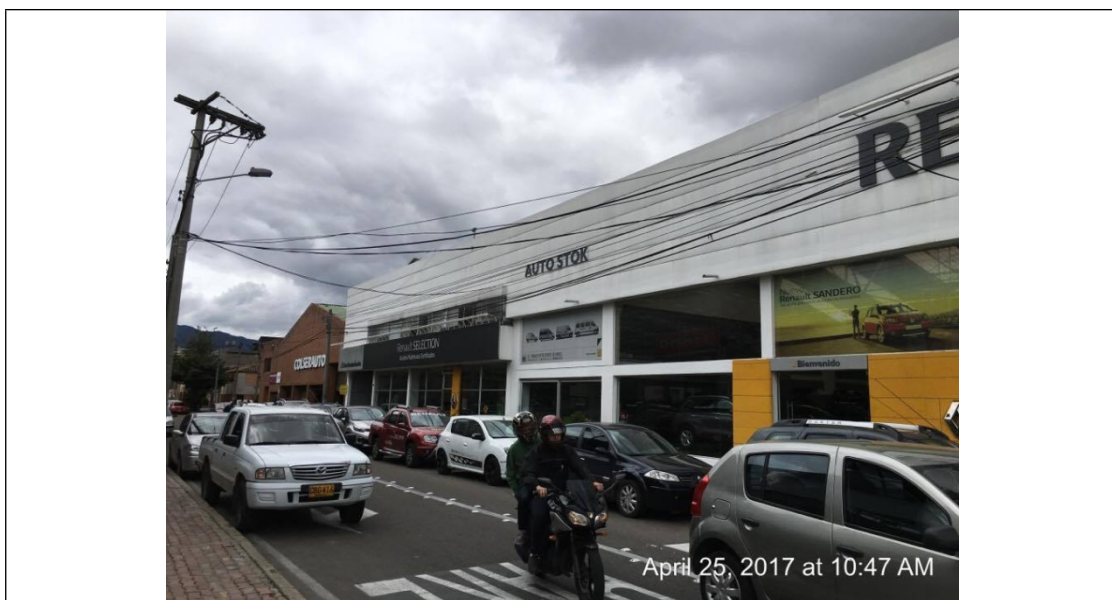
Fotografía No. 3 Vista panorámica del aviso en fachada del establecimiento comercial RENAULT, ubicado en la Avenida Carrera 70 No. 98 – 74, el cual no cuenta con registro.
